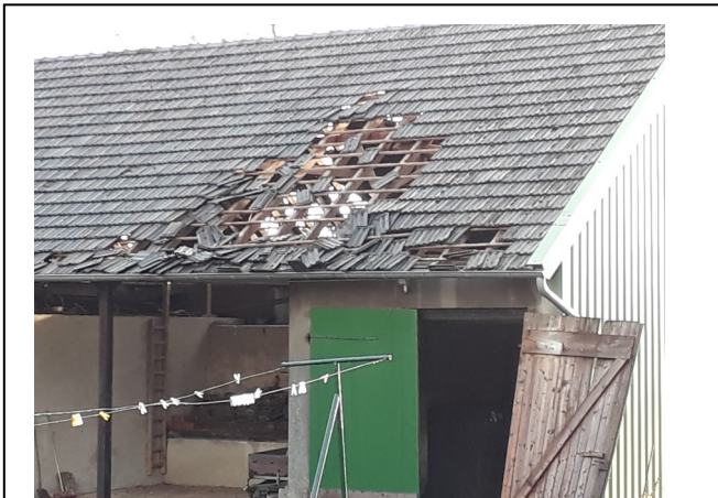
Dachschäden in der Imigstraße
